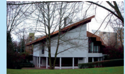
Gemeindezentrum West (GZW)
