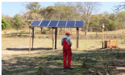
Die Solarzellen für den Brunnen sind montiert und die Pumpe läuft. Jetzt werden noch Wasserrohre verlegt.
