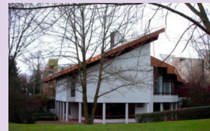
Gemeindezentrum West (GZW)
