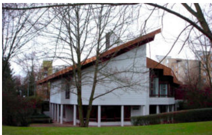
Gemeindezentrum West (GZW)
